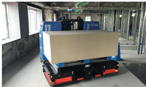
資材の水平搬送ロボット Robo-Carrier(ロボ・キャリアー)
